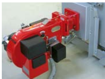
Bruciatore a gas bistadio per il funzionamento a carico piccolo ed a carico grande
