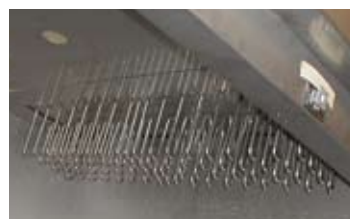
Batteria di riscaldamento per il modello elettrico
