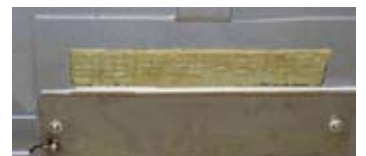
Segnalazione di rottura crogiolo sotto lo scarico d'emergenza di un forno fusorio
