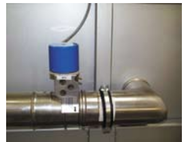
Valvole di regolazione motorizzate
