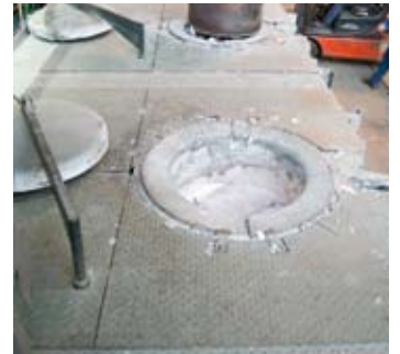
Piattaforma di caricamento su un K 360/12
