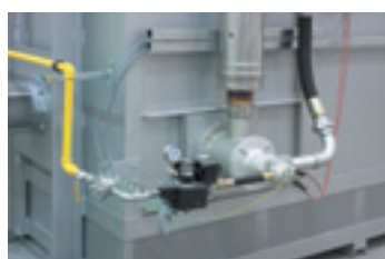
Riscaldamento indiretto a gas per mezzo di tubi radianti
