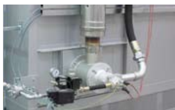
Alimentazione del gas lateralmente al forno
