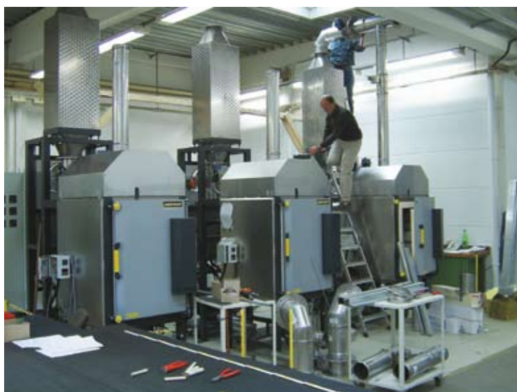
Impianto con forni a camera dotato di post-combustione catalitica in fase di installazione.
